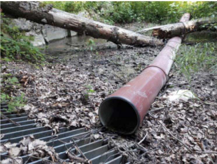
Das verfallene Retentionsbecken mit dem Abflussrohr, das vom Tagbauteich kommt am 22.7.2019 (vor den Sanierungsarbeiten). Es kommen gemessene 6 Liter in 23 Sekunden an, d.h. der Zulauf in den Tagbauteich in Trockenzeiten beträgt ca. 22.500 Liter/Tag. Das reicht nicht einmal zur Bewässerung der offenen Deponiefläche von 5.000qm, wozu 60.000 Liter pro 12 Std.-Tag benötigt werden.
