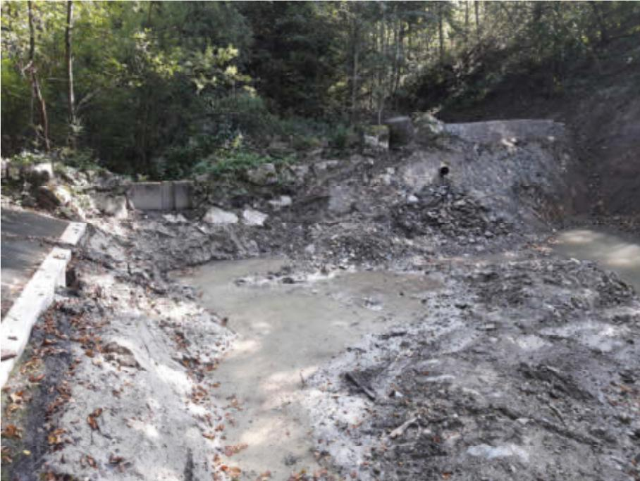
Das sanierte Retentionsbecken, wo die abgeleiteten Tagbauwässer als auch der Faistenbach im Boden versickern. (Quelle: Leuthäusser, 20.Sept. 2019)
